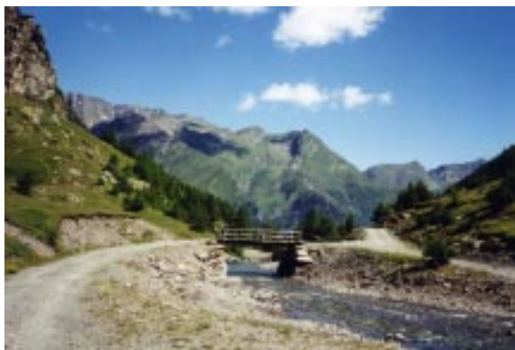
Un ponte sul Pellice sulla strada verso il Pra
