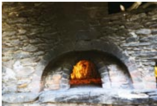
Uno dei vecchi forni a legna di Valle
